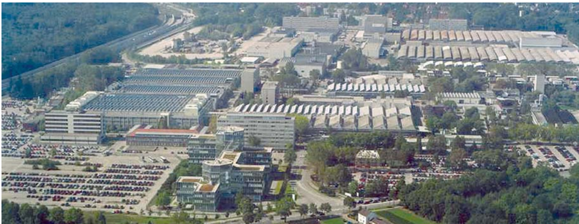
Das Firmengelände der MTU Aero Engines GmbH, dem führenden deutschen Triebwerkshersteller, befindet sich im Münchner Norden.
